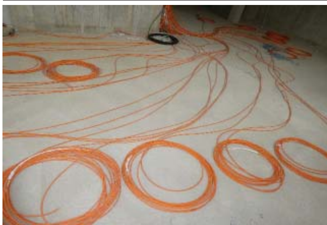
Noch müssen kilometerweise Kabel eingezogen werden...
