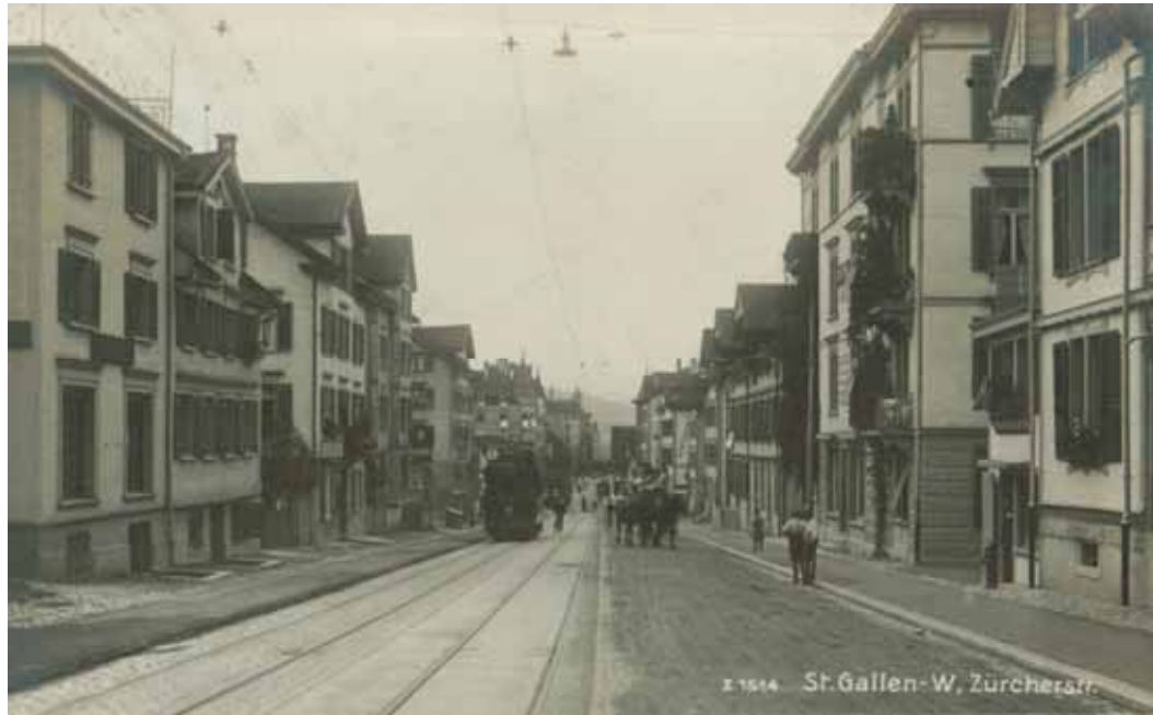
Höhe Zürcherstrasse 12 gegen Westen
