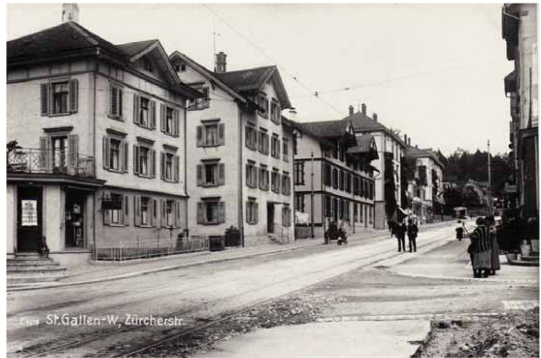
ab Zürcherstrasse 24 gegen Osten / Stahl
